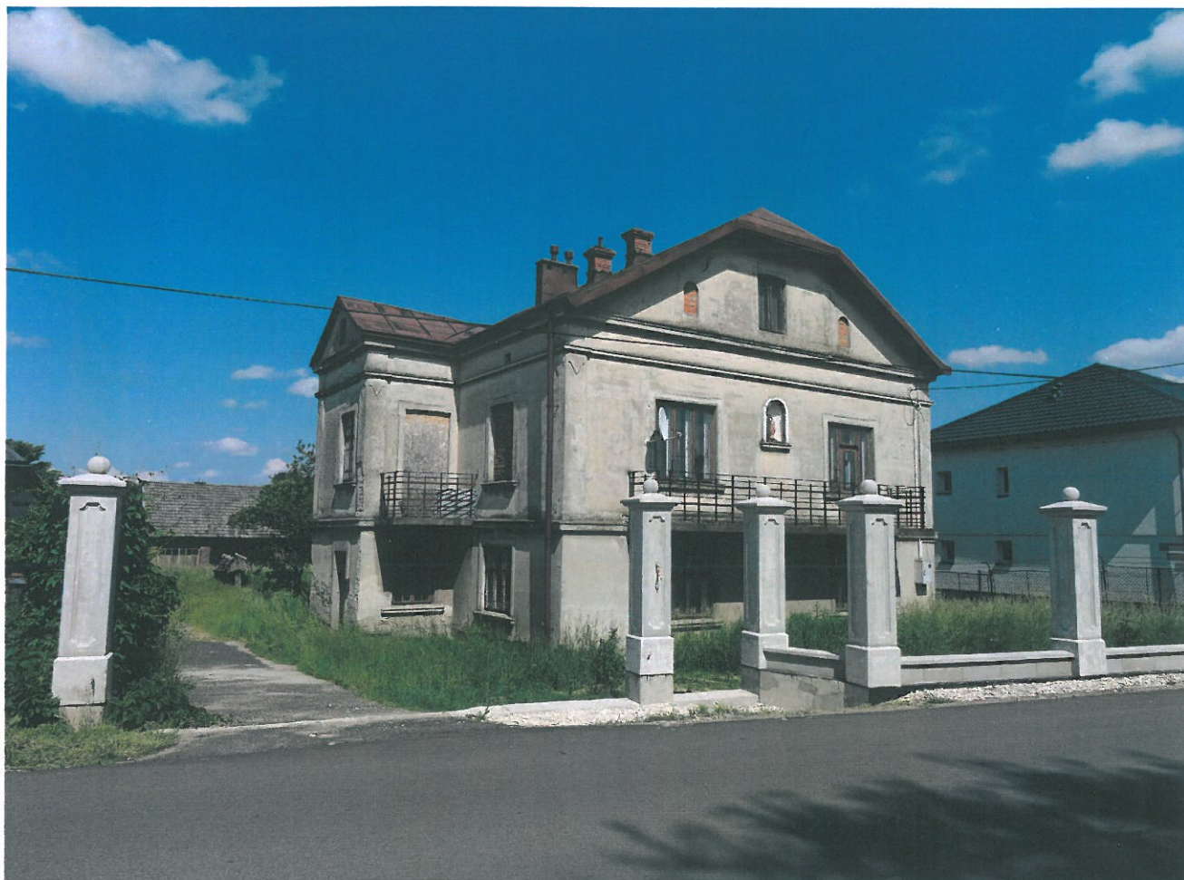
Widok od zachodu na elewację południowo-zachodnią i fragment elewacji północno-zachodniej
